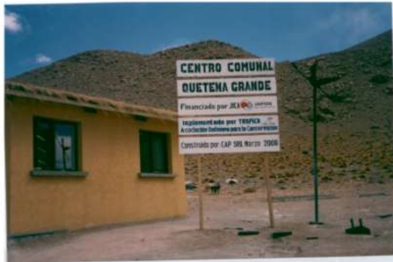
Centro Comunal en Polques (Cerrado no concluido)
